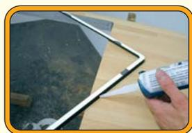
**4.** Nun wird in den äußeren Auflegefalz mit einer spitzen Silikonspritze umlaufend Silikon angegeben.
