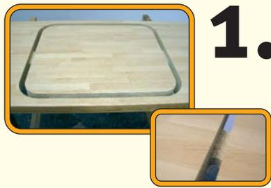
**1.** Mit einer Handsäge werden die Transportstege an der Arbeitsplattenkante abgeschnitten.
