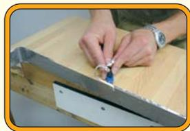
**3.** Das Klebeband wird an der Oberkante mit einem Messer sauber abgeschnitten, an der Unterkante wird es auf die Unterseite umgefalzt.
