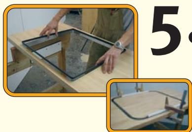
**5.** Der Inlayrahmen wird umgedreht und in die vorbereitete Öffnung eingelegt. Er kann mit kleinen Leisten als Pressulage und Klemmzwingen mit leichtem Druck auf die Arbeitsplatte gezogen werden. Am Rahmen seitlich austretendes Silikon nach dem Aushärten abziehen.
